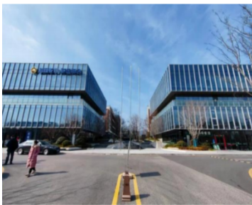
奥钜科技-招商蛇口.紫金智谷总部园智能建造示范基地
